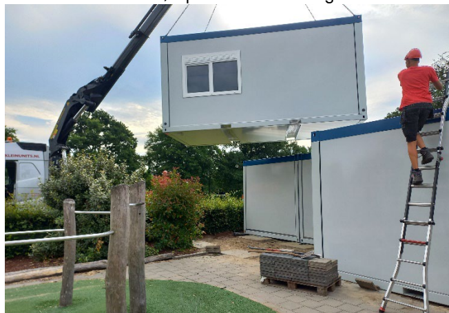
Klein Units verzorgde de plaatsing van de units, hier wordt de laatste unit geplaatst.
